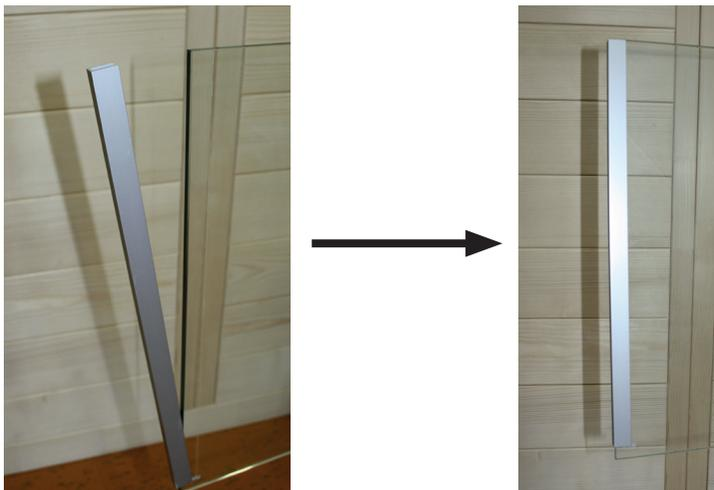
**Fig. 12: Inserimento della lastra di vetro nella scanalatura del montante angolare**
