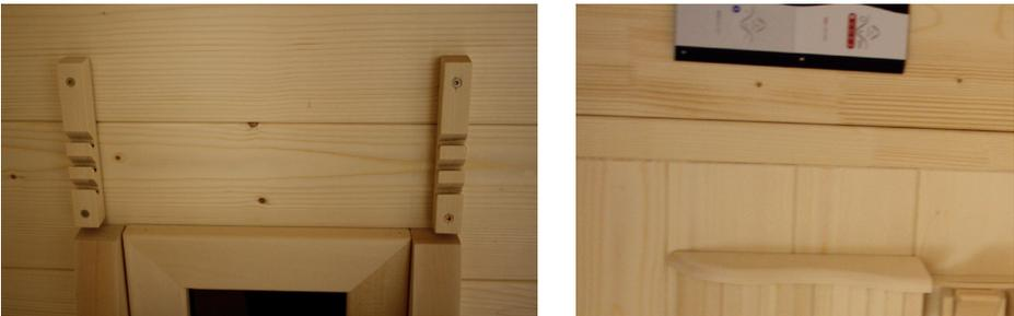
Avvitare i supporti a una distanza di almeno 1 cm dal bordo superiore del telaio, a filo con il lato del supporto degli schienali. L'altezza può essere variata a seconda delle esigenze. Quindi posizionare l'elemento del poggiatesta nella posizione desiderata.
