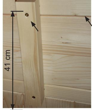
Avvitare i supporti della panca sul lato sinistro e destro interni della cabina e il listello del supporto della panca sull'elemento elettrico con 2 viti ciascuno.
