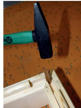
Battere con cautela i supporti a coda di rondine con un martello su entrambi gli angoli del telaio di base fino a quando non sono a filo con la scanalatura dell'elemento.
