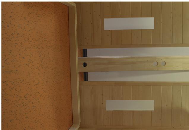
Posizionare un angolare premontato sul telaio di base, questo è collegato in modo non fisso alla scanalatura e alla linguetta.
