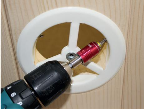
Avvitare l'elemento base della ventilazione con le 3 viti in dotazione.
