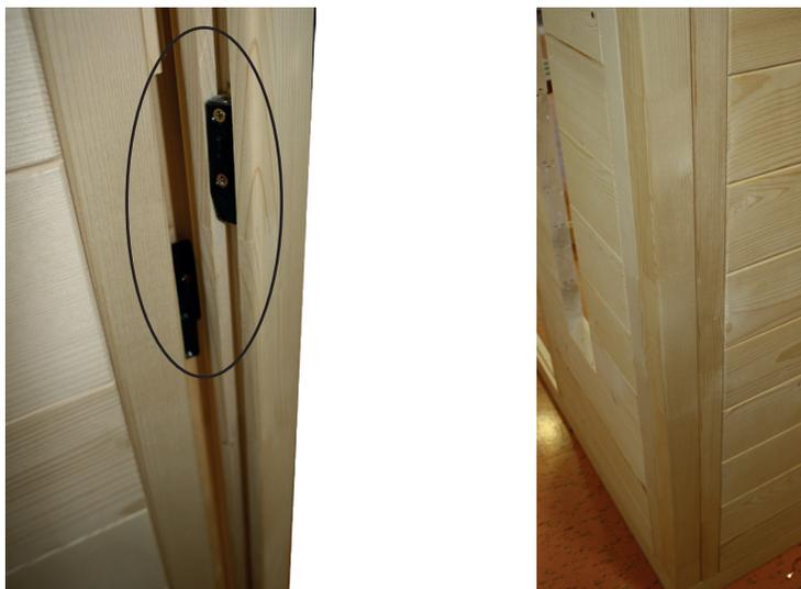
Innestare i montanti angolari dall'alto verso il basso sugli elementi parete. Nel farlo, prestare attenzione all'orientamento corretto delle "multiclip" (vedere Fig. 44). I montanti devono essere a filo con gli elementi parete.
