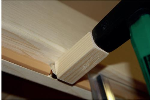
**Fig. 25: Montaggio della piastra a scorrimento**
