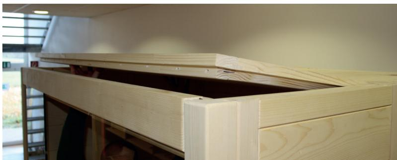
Dopo che gli elementi tetto sono stati inseriti, devono essere avvitati al listello di supporto del tetto.
