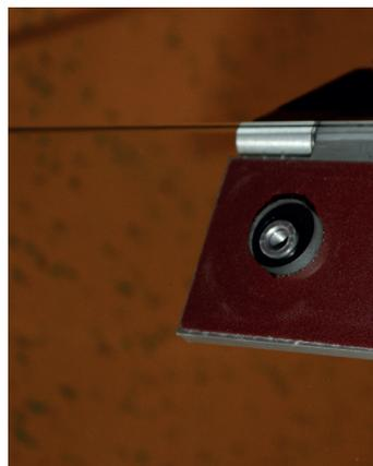
Avvitare entrambe le guarnizioni della porta all'elemento di fissaggio al vetro, assicurandosi che le guarnizioni siano allineate longitudinalmente e che la porta si apra verso l'esterno.
